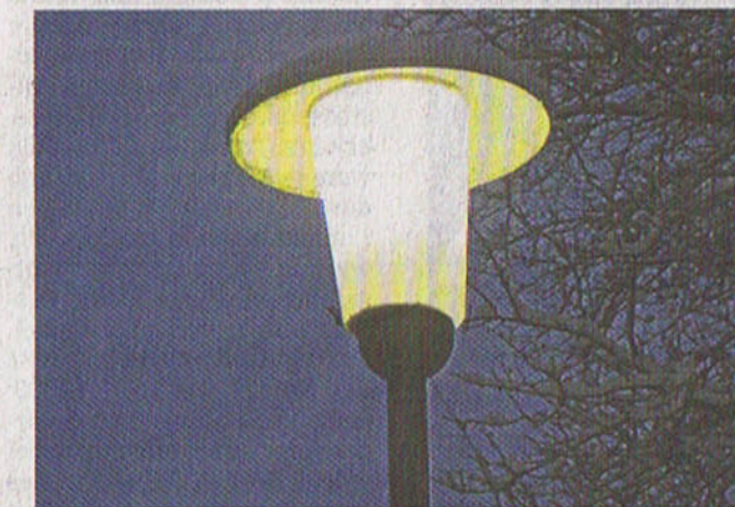
Die Straßenbeleuchtungen an der Dießener Straße, am Mühlenweg und im Peitingener Ortsteil Kurzenried bekommen sogenannte Induktivlampen.
